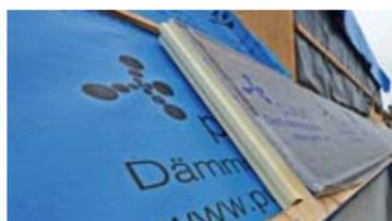
Das Dämmelement mit umlaufender Nut-Feder-Verbindung sichert über den Sparren eine wärmebrückenfreie Dämmschicht.
