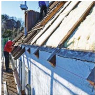
Abgeschnittene Sparrenköpfe erlauben eine einfache Führung der Luftdichtheitsebene. Der Dachüberstand wird über der Dämmung mithilfe der großen Konterlatten neu konstruiert.
