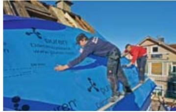
Einfache Verklebung der puren Konvektionssperre durch „Kleber-auf-Kleber-System“.
