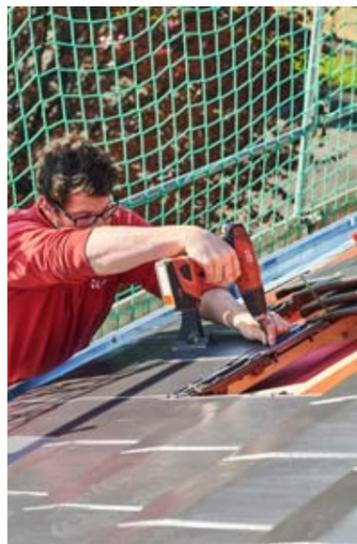
Nach der Verlegung wird die passend zum Flachziegel Actua 10 (Werk Langenzenn), hier in Edelgraphit, beschichtete Aluminium-Grundplatte im Kopfbereich mit zwei Schrauben in der Traglattung befestigt.
