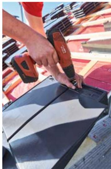
Am Ortgang ist Sturmfix 2.0 besonders wirtschaftlich und sicher: Durch die Verschraubung und zusätzliche Verklammerung erhält man doppelte Sicherheit.
