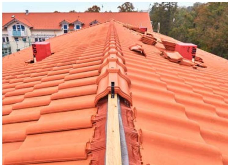
Mit optimal aufeinander abgestimmten Komponenten wie hier der Koramic-Unterdeckbahn Profi 2S, der First- und Gratrolle Universal, dem Flachdachziegel Alegria 12, dem Falzfirst Nr. 2 sowie den passenden Firstklammern lassen sich moderne Dächer fachgerecht in einem System erstellen.
