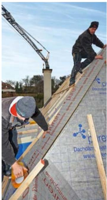
Mit dem selbstklebenden First- und Gratband von puren sind auch die Grate sicher, winddicht und wasserführend verklebt.
