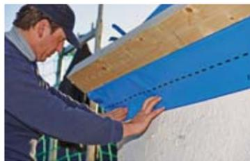
Ohne Unterbrechungen und in einer Linie wird die Luftdichtheitsebene sanft auf den Spezialkleber gedrückt.
