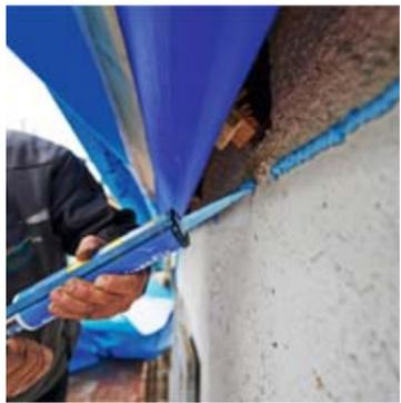
Die Luftdichtheitsebene wird mit puren AnschlussFix in einer Linie direkt an die Wand angeschlossen.
