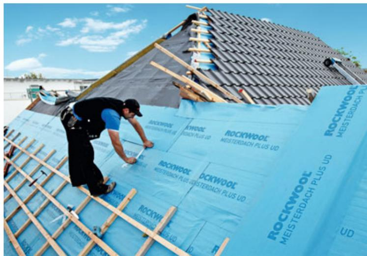
Kernstück des ROCKWOOL Meisterdachs: die hoch verdichtete Steinwolle-Dämmplatte Masterrock GF mit aufkaschierter, diffusionsoffener Unterdeckbahn.
