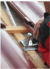
Die Befestigung des Venduct<sup>®</sup> Uniplus Solarhalter erfolgt auf dem Sparren. Dabei erleichtert das optimierte Lochbild die Positionierung.
