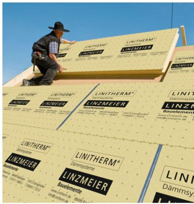
LINITHERM PAL N+F die sichere Dämmung für Dachneigungen ab 20 Grad ist Wärmedämmung, Unterdeckung, geeignet als Behelfsdeckung und bietet Schutz vor Elektrosmog
