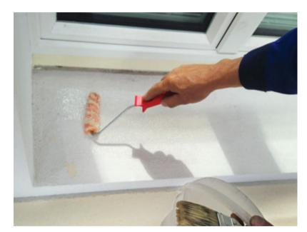
eine hervorragende Haftbrücke für zu verklebende Metallbauteile dar. Darüber hinaus beugt das Verfahren unbeabsichtigtem Eindringenden von Lösemitteln in das Dämmsystem vor. Der Verbrauch der Enke-Schutz-Haftgrundierung 2K beträgt ca. 400 g/m² – der Quarzsandverbrauch etwa 1,5 kg/m².
