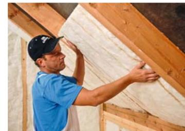
Der Dämmstoff URSA PUREONE ist weich und lässt sich dadurch flexibel in die Sparrenlage einsetzen.
