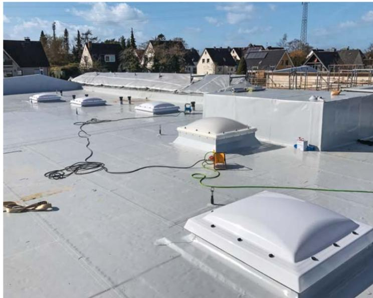
Alle Flächen wurden von den Profis der Heiko Muuss GmbH zügig wasserdicht hergestellt. Die Arbeiten an den Dachüberständen, die Verlegung der Wärmedämmung, die Abdichtung und der Einbau der Velux Flachdach-Fenster CVP erfolgten planmäßig und ohne Verzögerungen.
