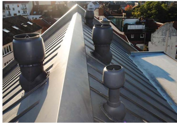
Passgenaue Lüftersysteme stehen für Stehfalzdeckungen zur Verfügung.
