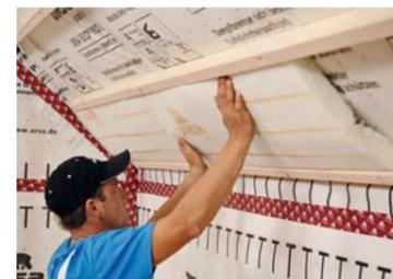
Als Ergänzung zur Zwischensparrendämmung und zur Reduzierung der Wärmebrücken kann URSA Pure 32 RW Untersparrenfilz angewendet werden.
